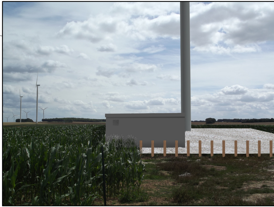
Après l'implantation de l'éolienne et du poste de livraison
